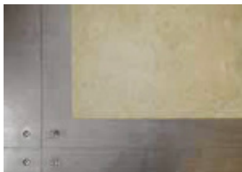
Figure 1 : Emplacement d'une dalle de 450 x 450 mm, qui doit être décalée de 75 mm de chaque bord d'un panneau de plancher surélevé.
